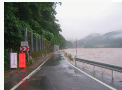
県道長井大江線の冠水で 高岡古屋敷地区が一時孤立
