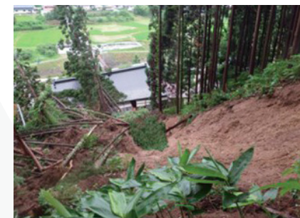
円光寺裏の土砂崩
