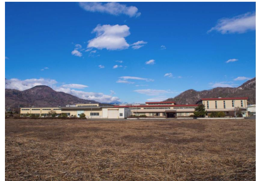
新たに整備する工場（現況）
