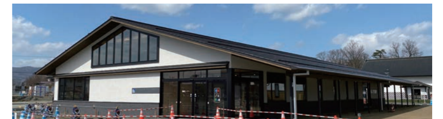
▲道の駅 石鳥谷 外観
