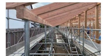
▲道の駅 石鳥谷 施工
