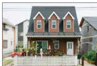
住房施工实例
