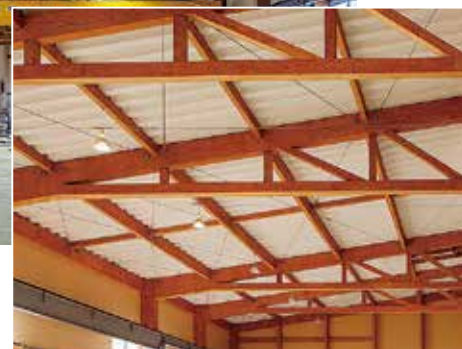
桁架结构在许多建筑物中可见。 JKHD 集团的 KEYTEC 工厂也是桁架构造
