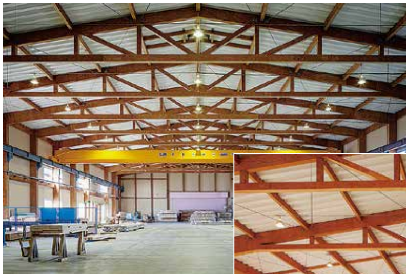
桁架结构在许多建筑物中可见。 JKHD 集团的 KEYTEC 工厂也是桁架构造
